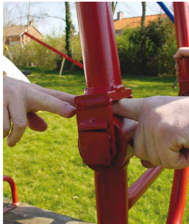
Onveilige speeltoestellen kunnen zorgen voor bekknelling van de vingers bij een familieschommel of voetbeknelling bij de "oceaangolf"
